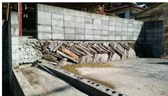
中田地区に見られる変成岩を利用した「矢羽根積み」擁壁
